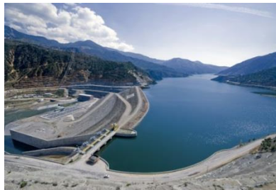
Figure 6. Obruk Dam in Çorum [28]
