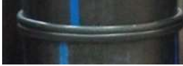
Şekil 3. Sıcak eleman alın kaynak yöntemiyle birleştirilen HDPE 100 borunun dış birleştirme bölgesi
