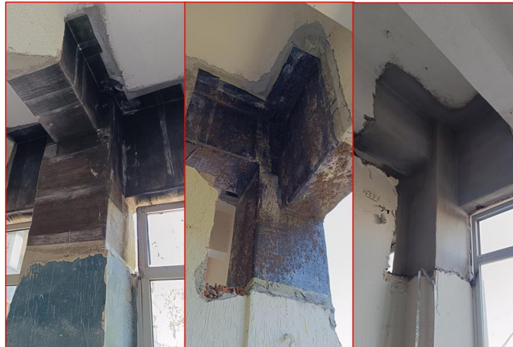
Şekil 7. Birleşim noktalarında uygulanan CFRP işleminin son hali
