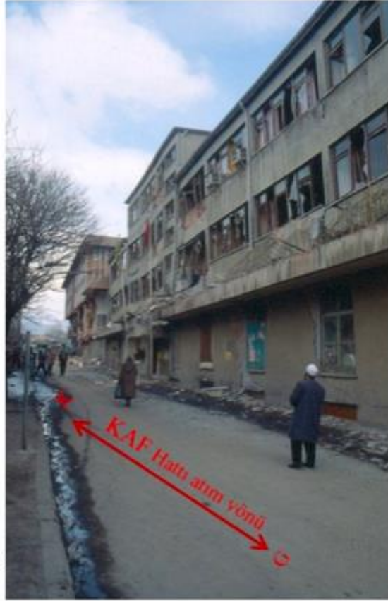
Fotoğraf 3: KAF Hattının atım yönüne uzun kenarı paralel olan ve konstrüktif hasar görmemiş bina. Arka planda KAF hattının geçtiği Kuzey Anadolu Sıradağları (13 Mart 1992 Erzincan Depremi, Mw=6,8)
