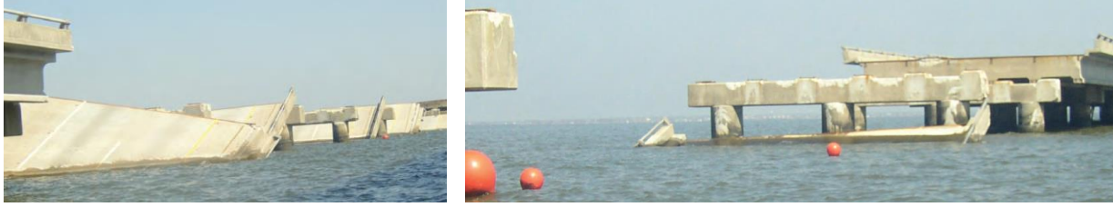
Şekil 2. Katrina Kasırgası Sonrası I-10 Otoyol Köprüsündeki Zarara Dair Görseller (Kaynak: USGS)
