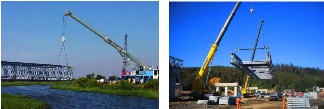
Şekil 5. Vinç Destekli/Kaldırma Tekniği ile Köprü Montajına Dair Görseller (Temsili)
